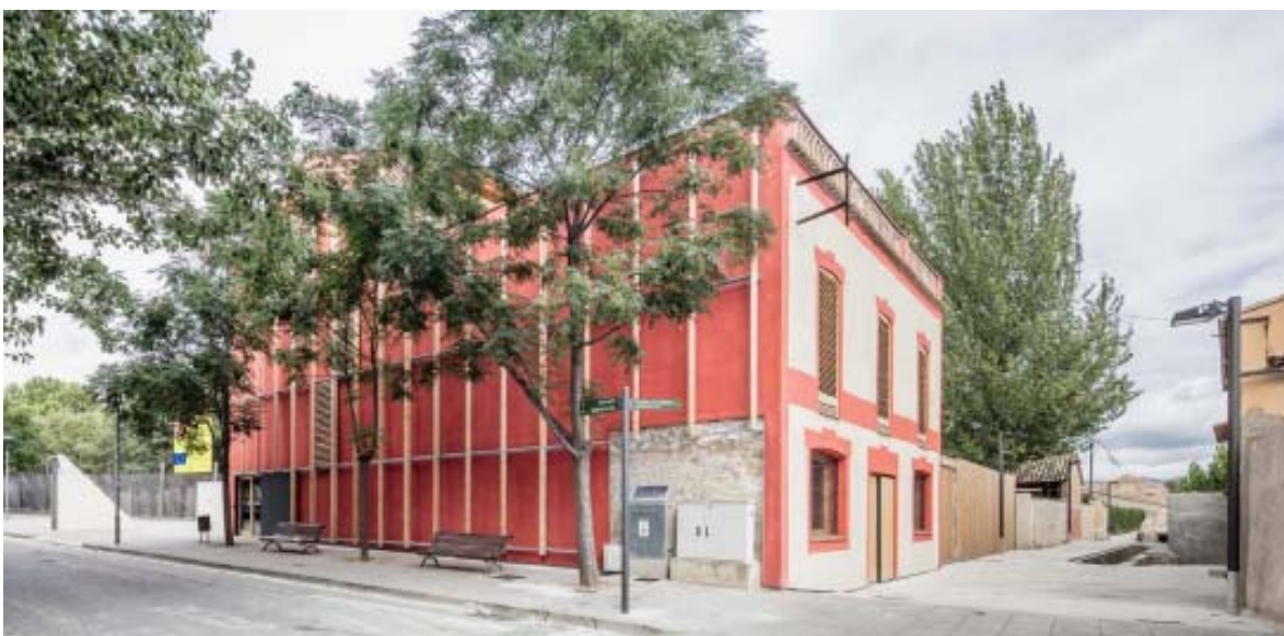
Vista general des del carrer de l'edificació
