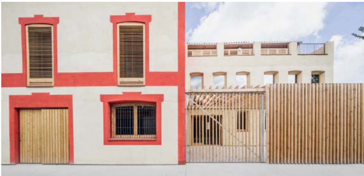
Façana Camí del Rec edificació
