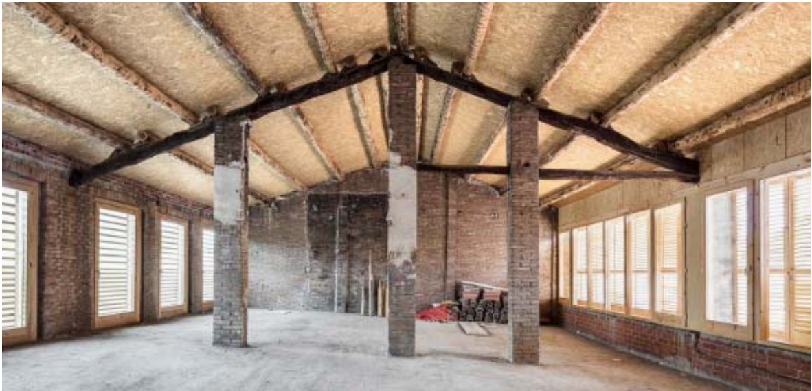
Interior planta sotacoberta
