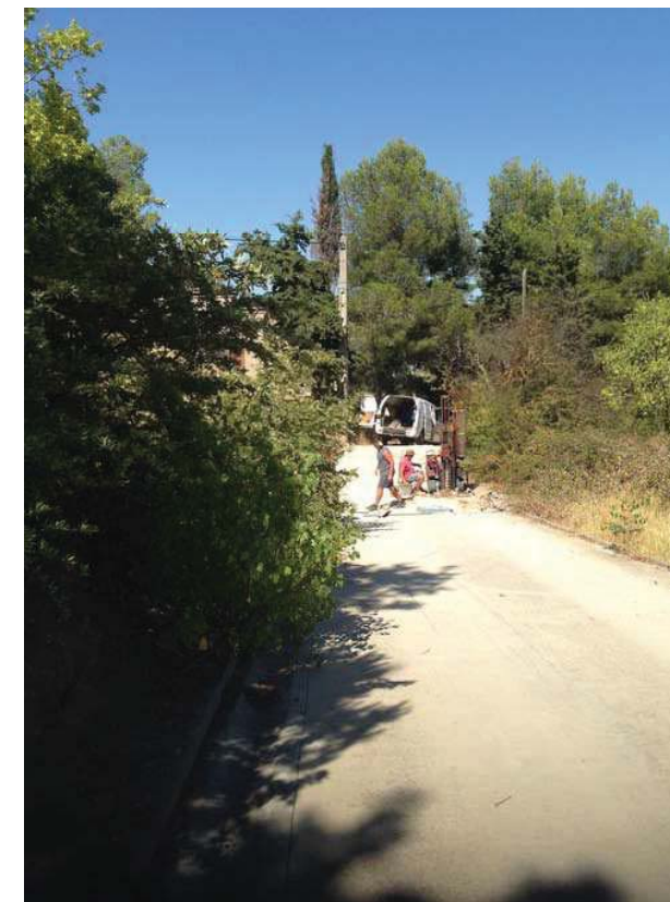
Fotografia de l'emplaçament de la sonda en el punt de sondeig S-2 amb una fondària de reconeixement assolida de 4,00 m.
