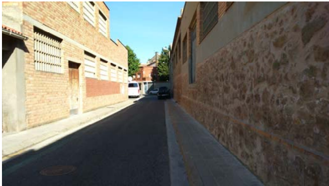
Imatge 4. Travessia dels Traginers.
