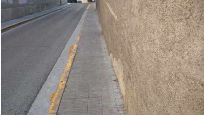
Imatge 2: vorera est del c/ dels Traginers.
