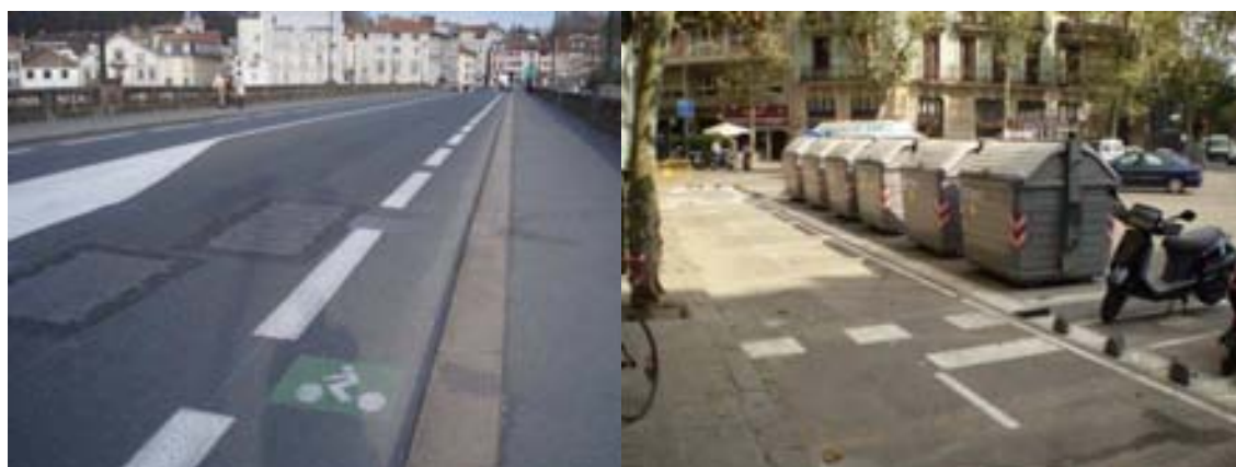
Figura 16: Exemples de vies ciclistes segregades en calçada: Carril bici i Carril bici protegit
