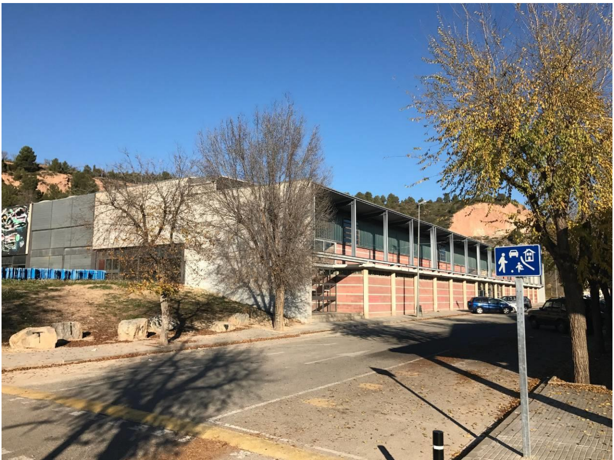
Façana de connexió amb la nova pista poliesportiva
