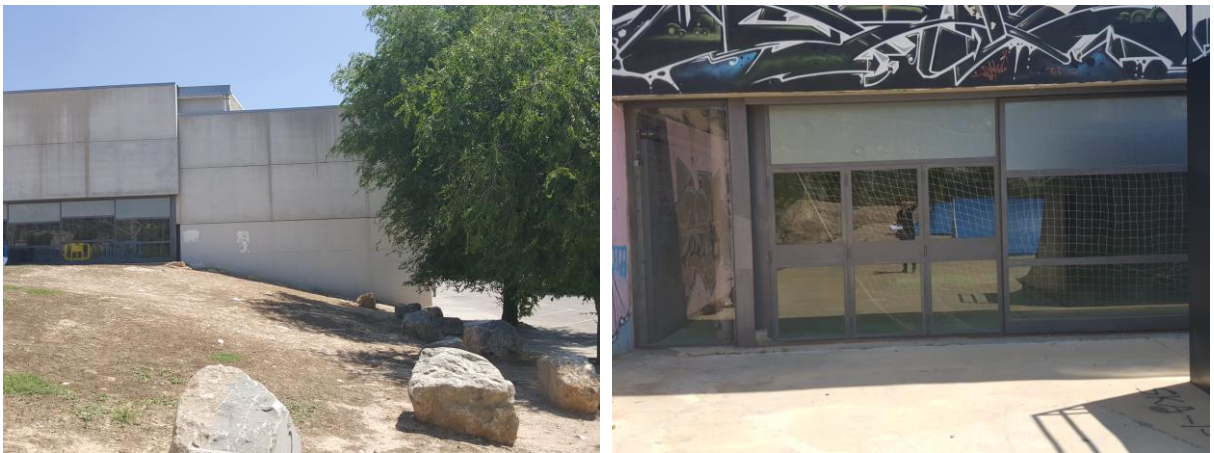
Façana oest del poliesportiu existent colindant amb el nostre solar on actuar
