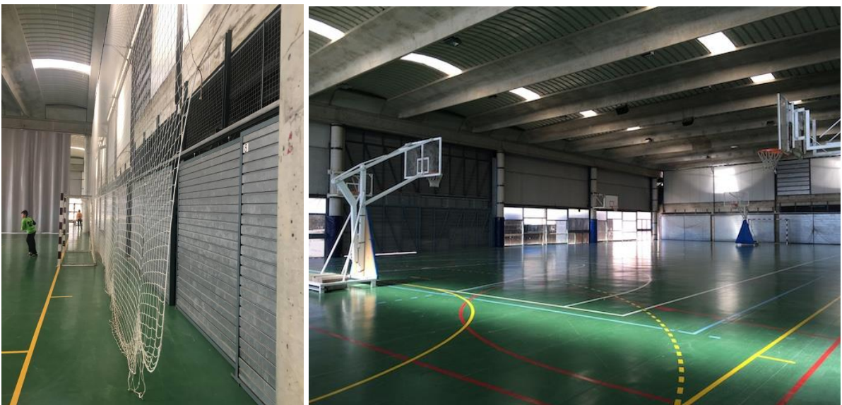
Façana de les pistes poliesportives existents, col·lindant amb nova pista
