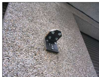
Instal·lació de clinòmetre en façana
